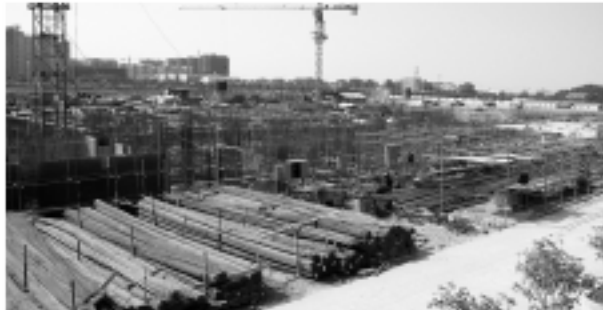
汇锦国际工地
